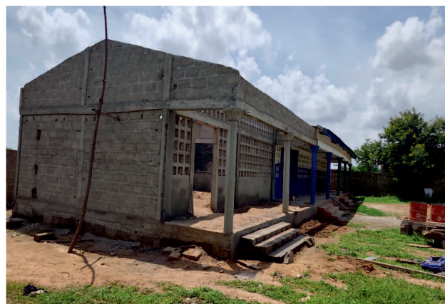
Hier entsteht das neueste Schulzimmer des Collège in Sagbièbou
