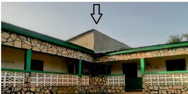
Zusätzliches Mauerwerk, um das Dach der Eingangshalle endlich dicht zu bekommen
