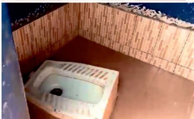
Die schwierig zu reinigenden Schultoiletten in Davié aus Rohbeton erhielten eine leichter waschbare und schneller trocknende Oberfläche.
