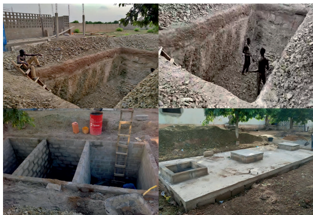
Bau der Zisterne für Regenwasser in Sagbiébou
