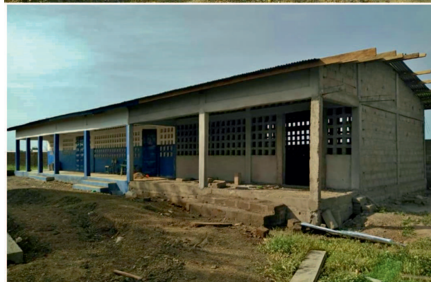
Das Schulzimmer für die vierte Klasse in Sagbiébou wird angebaut
