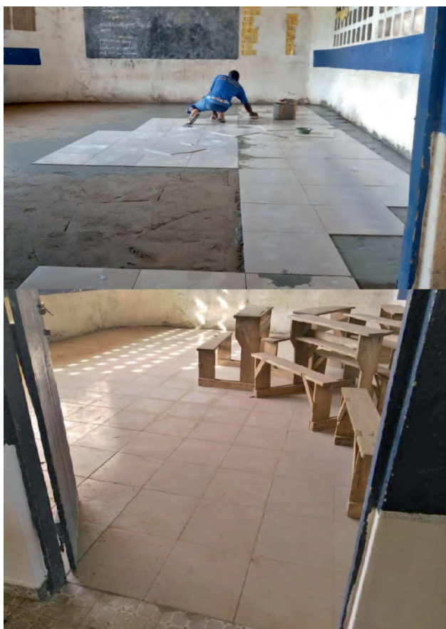
Der Boden des Alphabetisierungszimmers/Schulzimmers der Erstklässler in Sagbiébou hat einen neuen Boden bekommen
