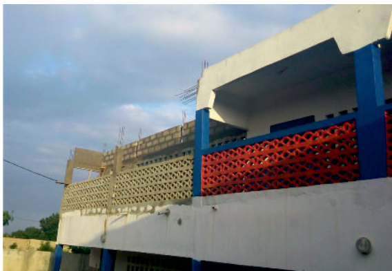
Das vierte Schulzimmer wird gebaut im Juli 2016
