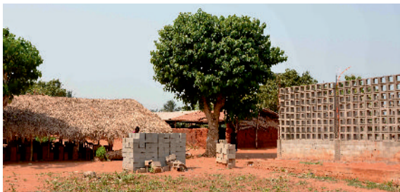
links: provisorisches Schulzimmer mitte: eines der Hauptgebäude rechts: Baustelle für neue Schulzimmer
