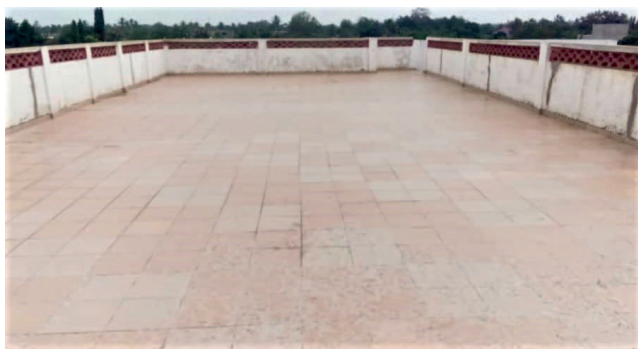
Das Flachdach der Schule in Davié wurde gefliest
