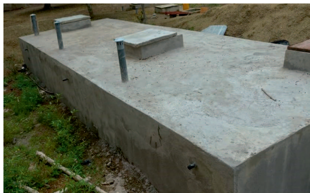
Eine zweite Zisterne für Regenwasser wurde in Sagbiè-bou gebaut
