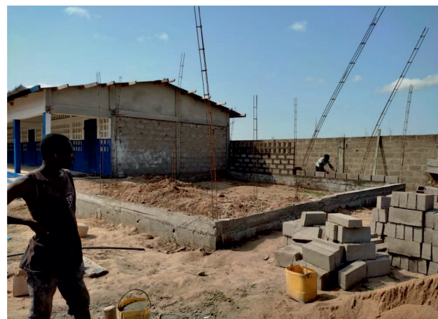
Beginn der Bauarbeiten
