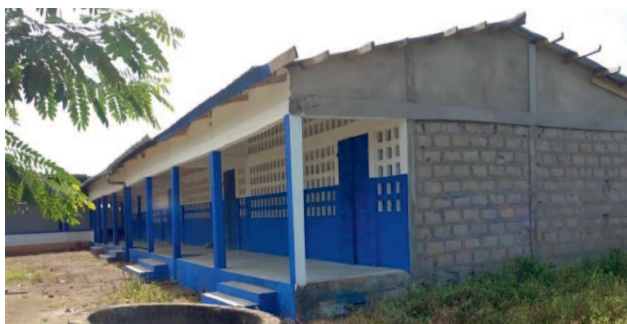
Das Schulgebäude in Sagbiébou wächst in die Länge 4 von 6 Schulzimmer sind fertiggestellt
